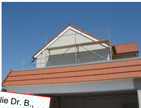
Baubeginn bei Fam. Dr. K., Bad Fischau-Brunn, April 07
